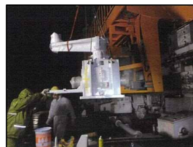
分岐器 減速機交換作業
