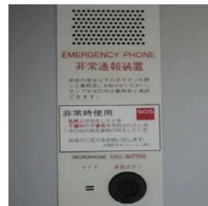
車両連結部 非常通報装置
