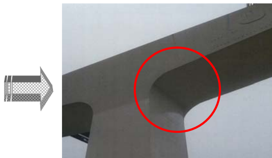
施工後（曲線の化粧板を取り外しました）
