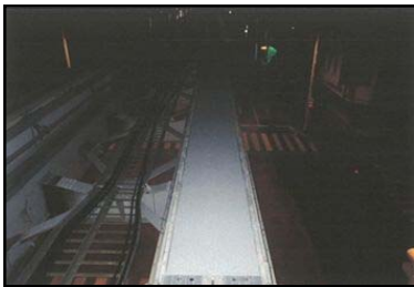
鋼軌道桁走行面滑り止め塗装
