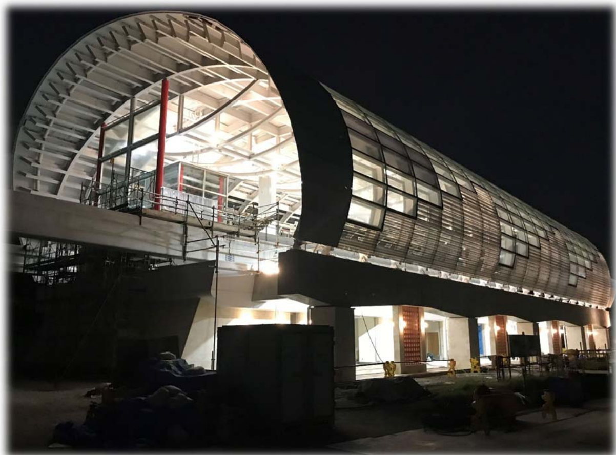
沖縄都市モノレール線延長部の終点「てだこ浦西駅」
