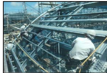
駅舎建築工事
