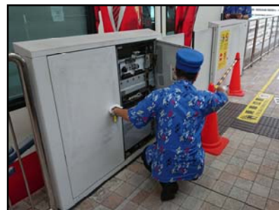
ホームドア復旧訓練
