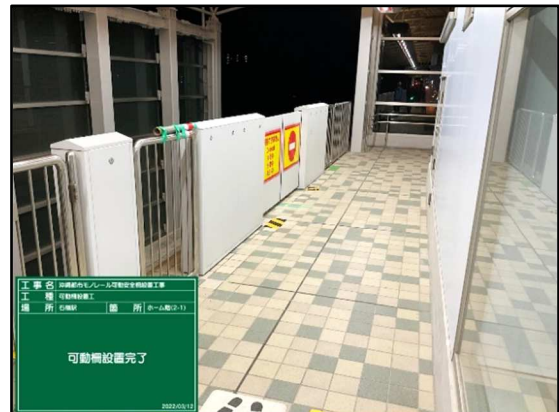
ホームドア(可動安全柵) 設置後
