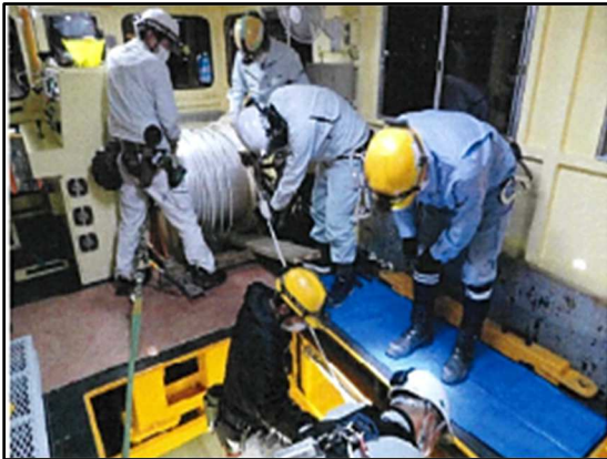
電車線取り替え作業の様子
